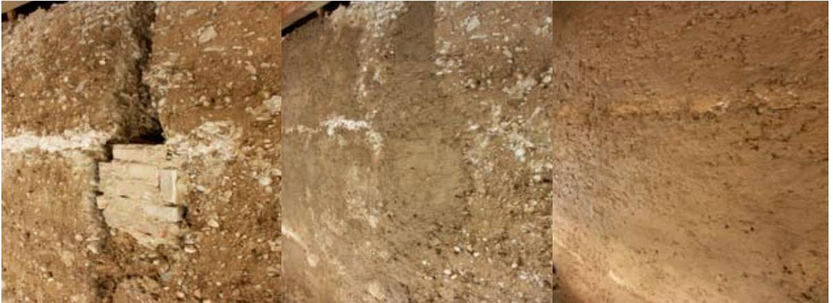
Enfin la composition très graveleuse de ce mortier permet d'éviter les fissures de retrait et de faciliter sa mise en oeuvre. Ce mortier ainsi fabriqué est utilisé tel quel pour reprendre en sous-œuvre les angles fragilisés, les trous du pisé, les fissures et voire même un ensemble de mur en pisé. Pour les reprises en sous-œuvre des soubassements, il est recommandé de le stabiliser avec un liant hydraulique pour éviter l'apparition d'un sillon destructeur à la base d'un mur.
