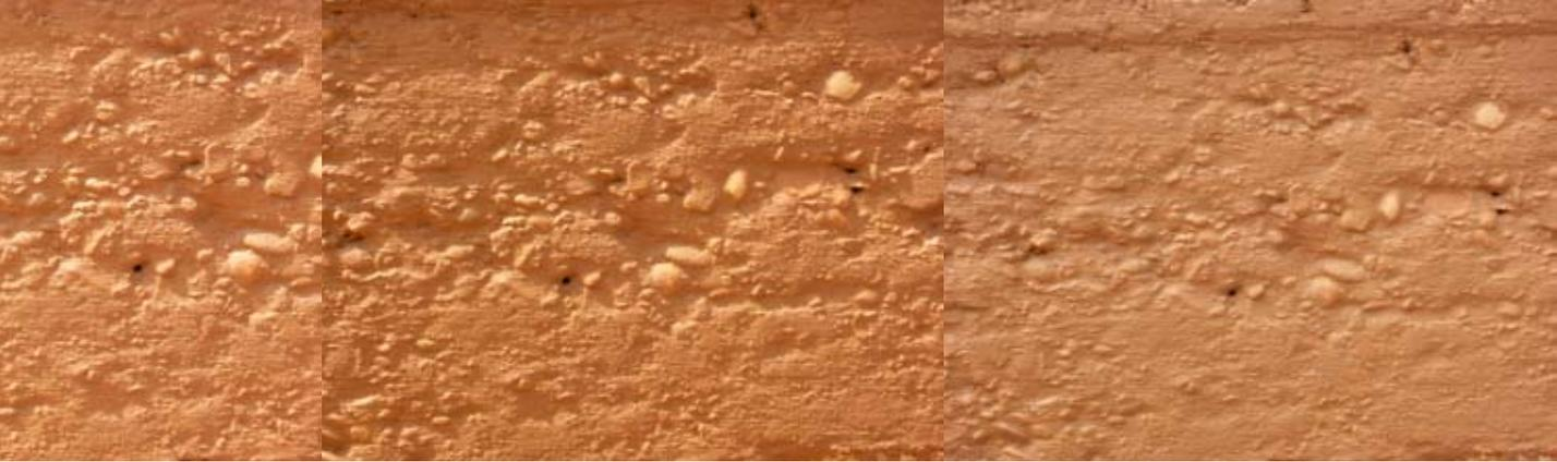
En passant un badigeon à l'eau sur la surface du mur avec un pinceau brosse, on disperse les plaquettes d'argiles par une action mécanique. Ce geste de trituration des grains entre eux, répété une dizaine de fois avec le pinceau, fabrique un mortier de surface qui stabilise le pisé en le rendant plus homogène. Les argiles contenues en faible quantité dans le mur jouent alors le rôle de colle entre les différents éléments : sable et graviers, redonnant au pisé une surface régulière et stabilisée.
